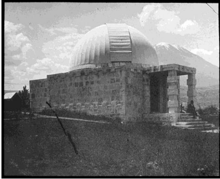
Arequipa-Peru met de Bruce dome.
